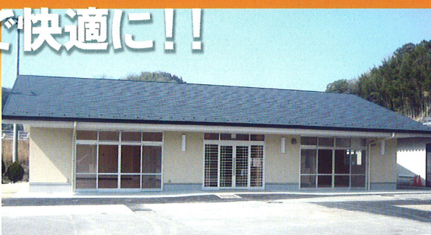
▲明るく、快適な建物ができました
