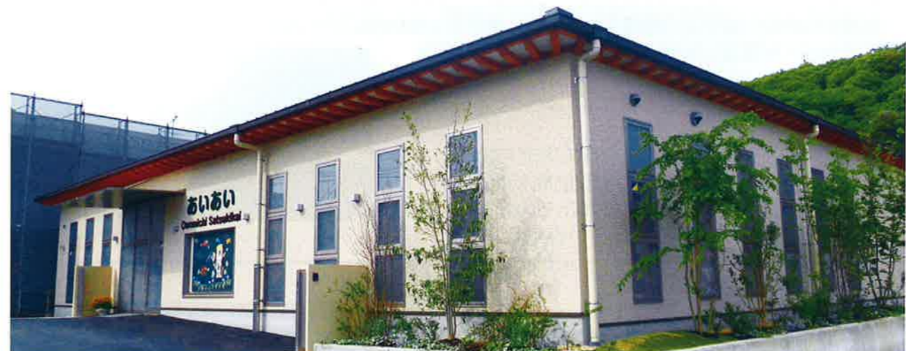
▲新しい園舎の外観
